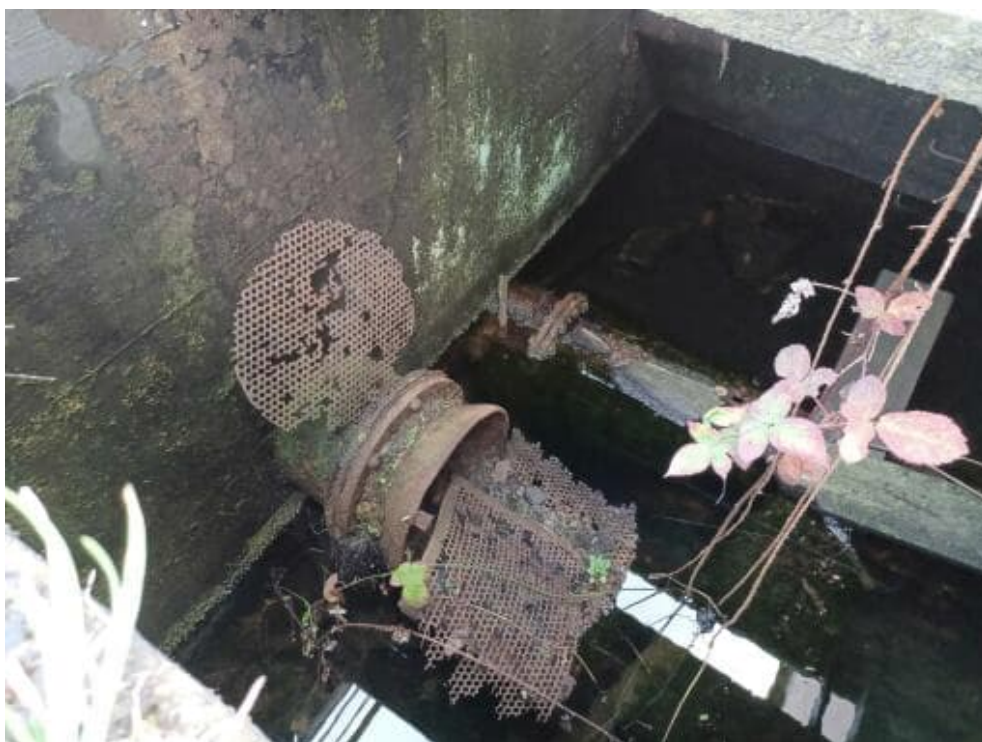
Bild 178: N70 Antriebstechnik korrodiert, Korrosionsschutz nicht vorhanden.
