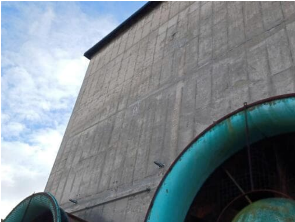
Bild 169: N67 Betonabplatzungen mit freiliegender Bewehrung und fortgeschrittenem Querschnittsverlust. Beobachtung ist auf gesamter Bauteilhöhe vereinzelt feststellbar.
