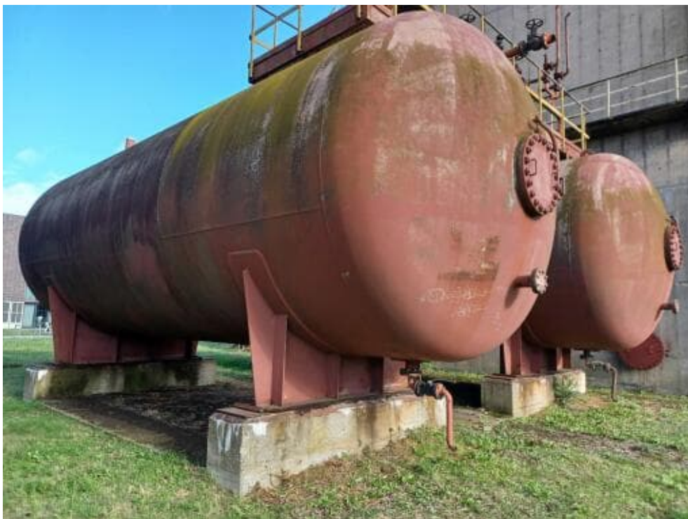
Bild 202: N78 Korrosionserscheinungen an Fußpunkten
