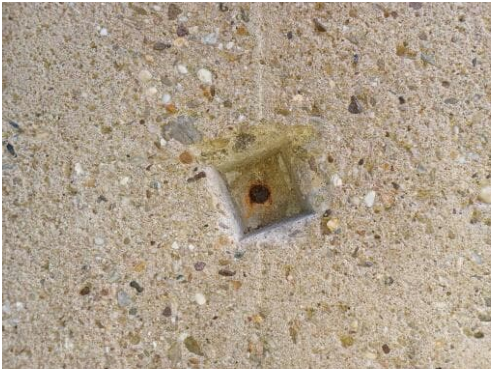
Bild 195: N75 Rechteckiger Ankerpunkt 4 x 4 cm, t = 3cm vorhanden Abdeckung aus Mörtel
