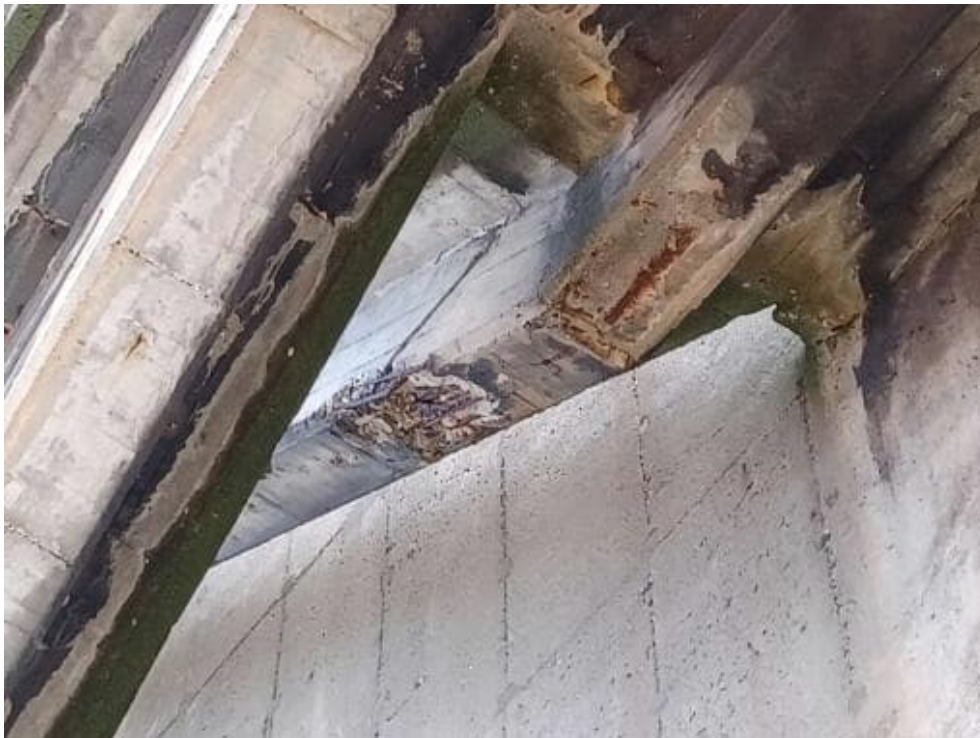
Bild 187: N72 Betonabplatzungen mit freiliegender Bewehrung und fortgeschrittenem Querschnittsverlust. Beobachtung ist mehrfach entlang Treppe feststellbar. Plattendicke: 10 cm Geländer abgängig Ausbrüche vorhanden
