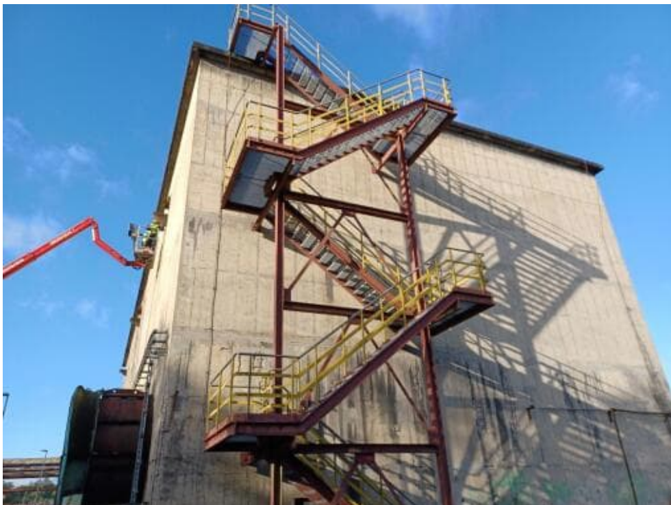
Bild 140: N60 Fußpunkte exzentrisch auf Fundament angeordnet. Abmessungen: b=h=50\text{ cm} (vgl. Ventilatorenkühler III) Treppenturm ist generell in einem guten Zustand. Korrosionsschutzbeschichtung ist abhängig.
