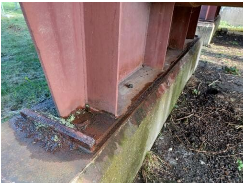
Bild 200: N78 Korrosionserscheinungen an Fußpunkten
