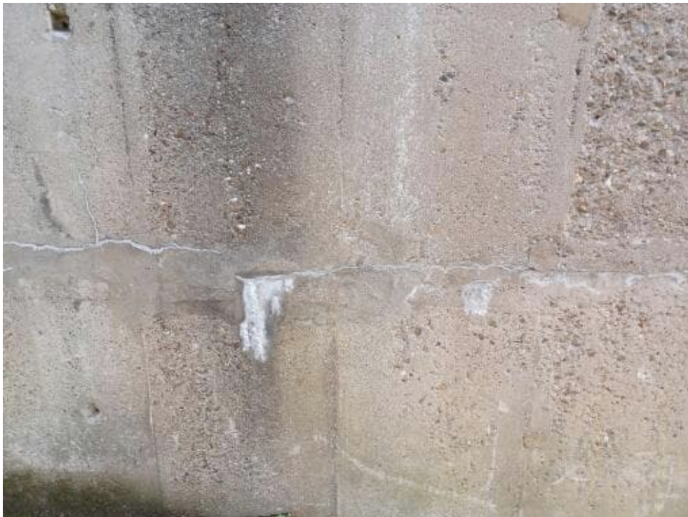
Bild 189: N73 Aussitterungen entlang Betonierfuge
