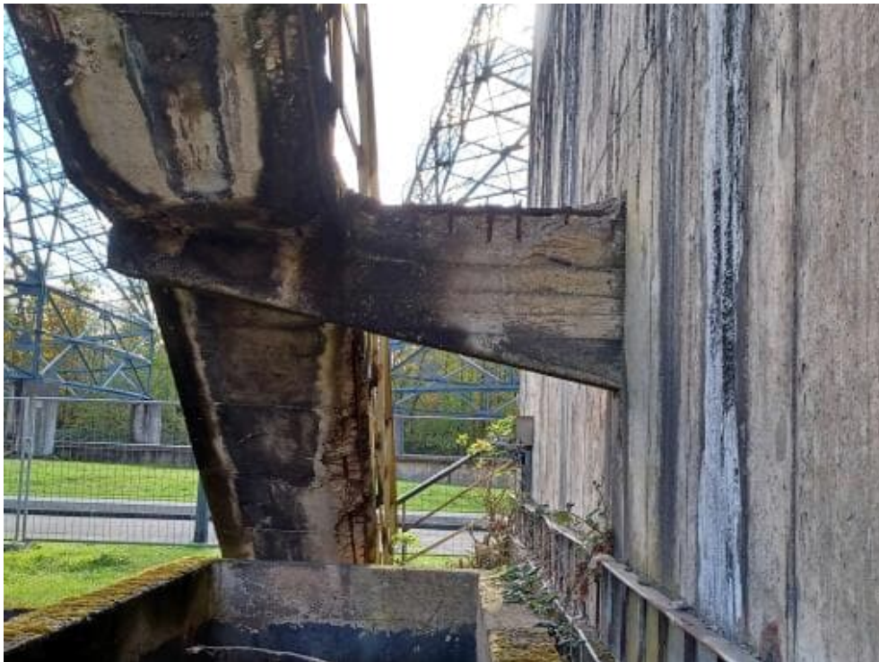
Bild 203: N79 Betonabplatzungen mit freiliegender Bewehrung und fortgeschrittenem Querschnittsverlust. Beobachtung ist mehrfach entlang Treppe feststellbar. Plattendicke: 10 cm Geländer abgänglich Ausbrüche vorhanden
