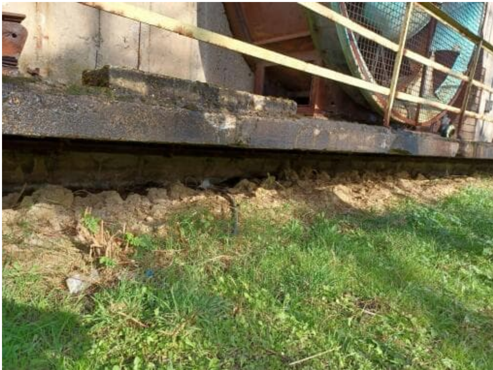
Bild 199: N77 Lichte Höhe unter Kragplatte: 60 - 70 cm
