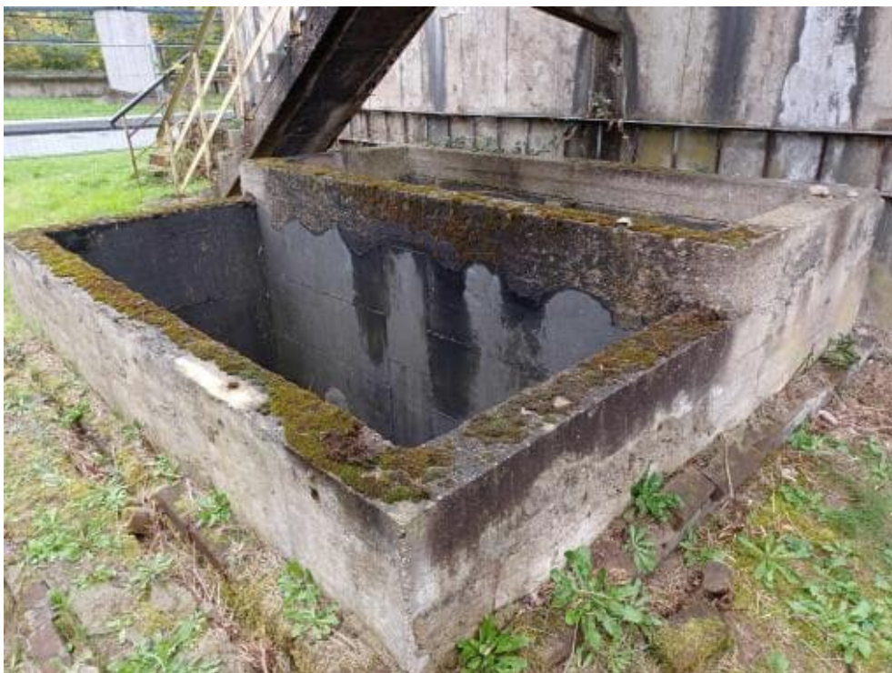
Bild 6: N4 Probe S3 Schadstoffanalyse Schwarzer Anstrich
