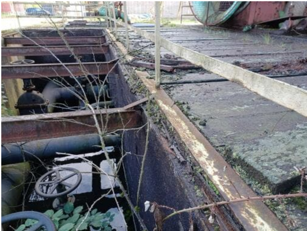
Bild 163: N66 65mm breit, 140mm hoch, I-Profil, Korrosionsschutzbeschichtung abgängig Länge Träger ca. 2,10 m
