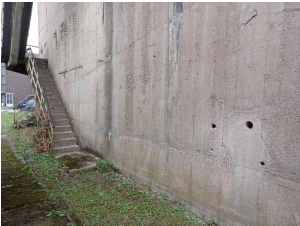
Bild 27: N16 Bewehrungsdetektion horizontal, 2x vertikal FS 690-692
