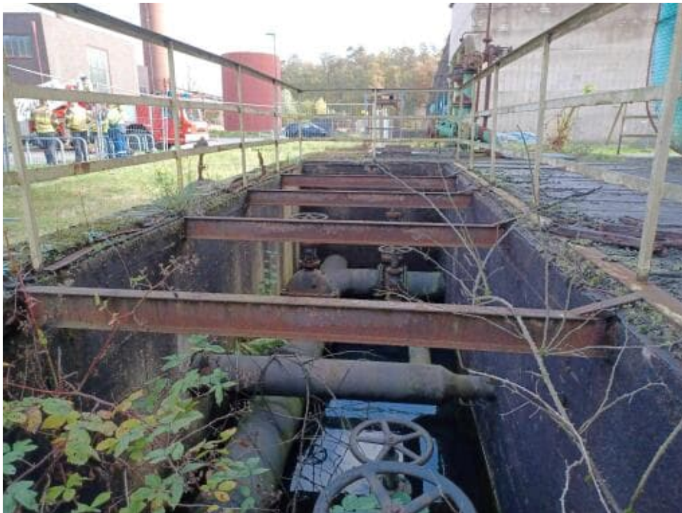
Bild 167: N66 65mm breit, 140mm hoch, I-Profil, Korrosionsschutzbeschichtung abgängig Länge Träger ca. 2,10 m
