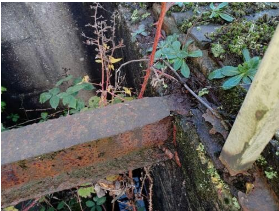
Bild 164: N66 65mm breit, 140mm hoch, I-Profil, Korrosionsschutzbeschichtung abgängig Länge Träger ca. 2,10 m
