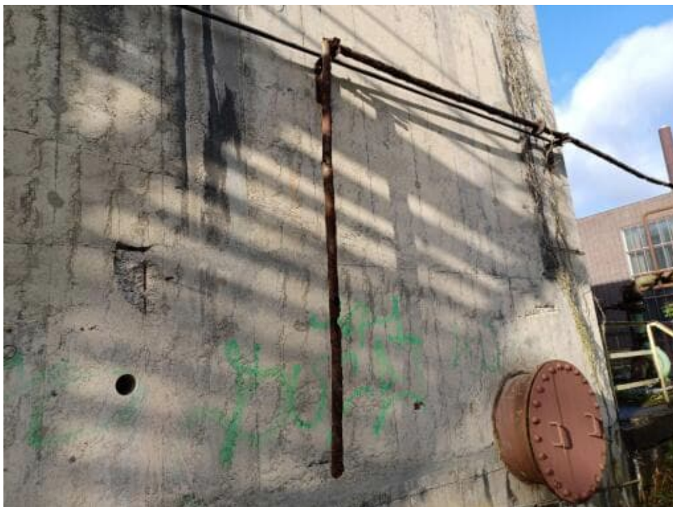
Bild 146: N62 Stahlanbauteile korrodiert
