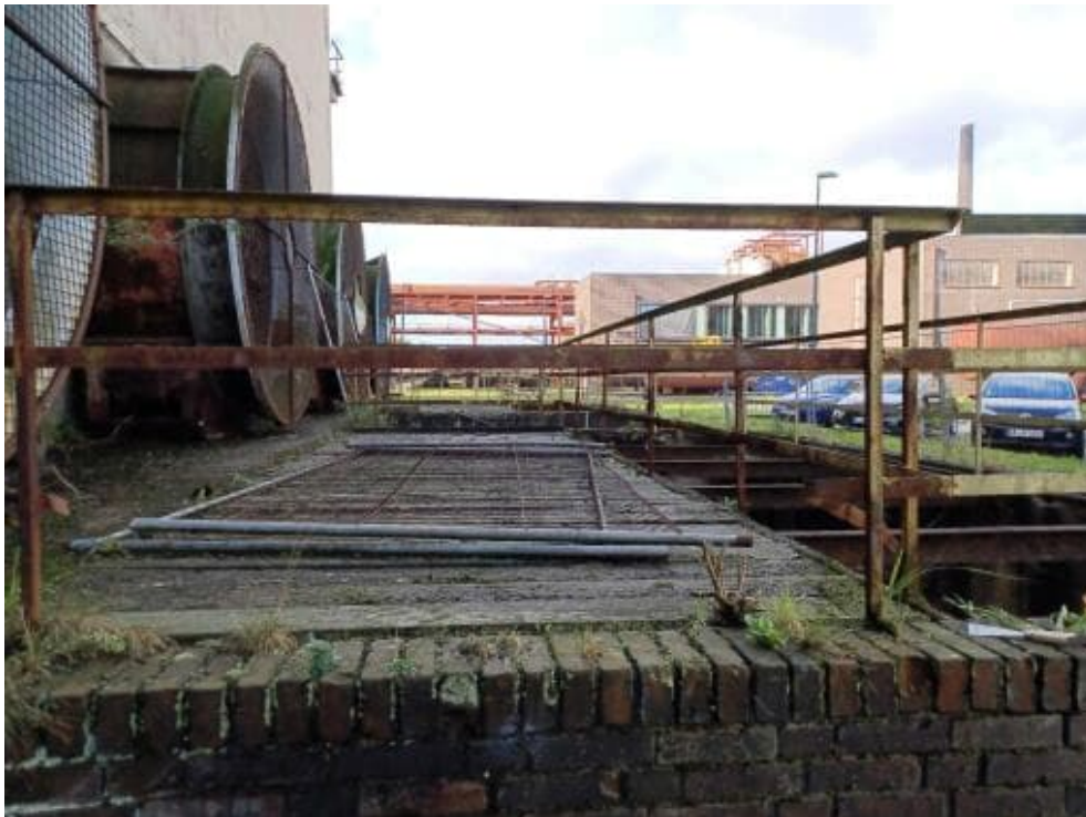
Bild 157: N64 Stahlgeländer stark abgängig bzw. nicht vorhanden -> nicht funktionsfähig
