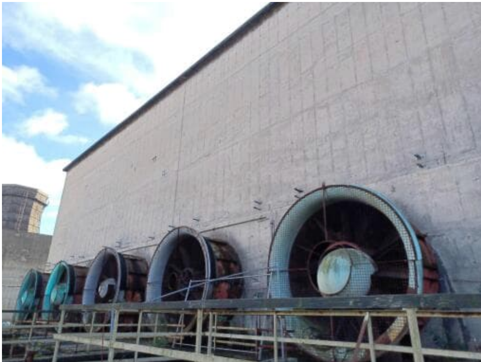
Bild 171: N68 Ventilatoren sind stellenweise durchkorrodiert. Korrosionsschutz nicht mehr vorhanden. Schädigungsgrad variiert.
