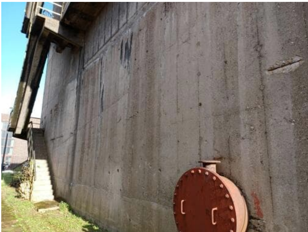
Bild 194: N74 Betonabplatzungen mit freiliegender Bewehrung und fortgeschrittenem Querschnittsverlust. Beobachtung ist auf halber Bauteilhöhe mehrfach vorhanden. Hohllagen auf gesamter Bauteilhöhe vorhanden.
