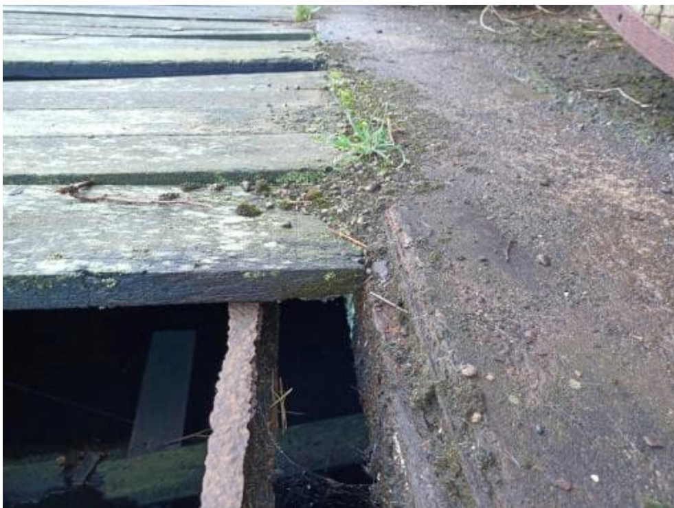
Bild 172: N69 Vorkoammern mit Holzbohlen abgedeckt
