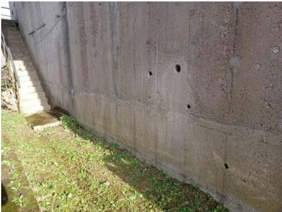
Bild 190: N73 Aussitterungen entlang Betonierfuge
