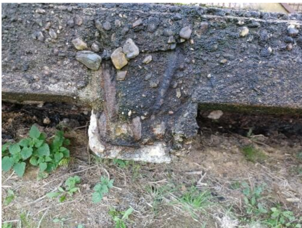
Bild 213: N84 Vouten unter Kragplatte Lichte Bauteilhöhe 50 - 60 cm
