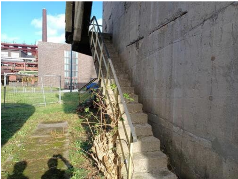
Bild 188: N72 Betonabplatzungen mit freiliegender Bewehrung und fortgeschrittenem Querschnittsverlust. Beobachtung ist mehrfach entlang Treppe feststellbar. Plattendicke: 10 cm Geländer abgängig Ausbrüche vorhanden
