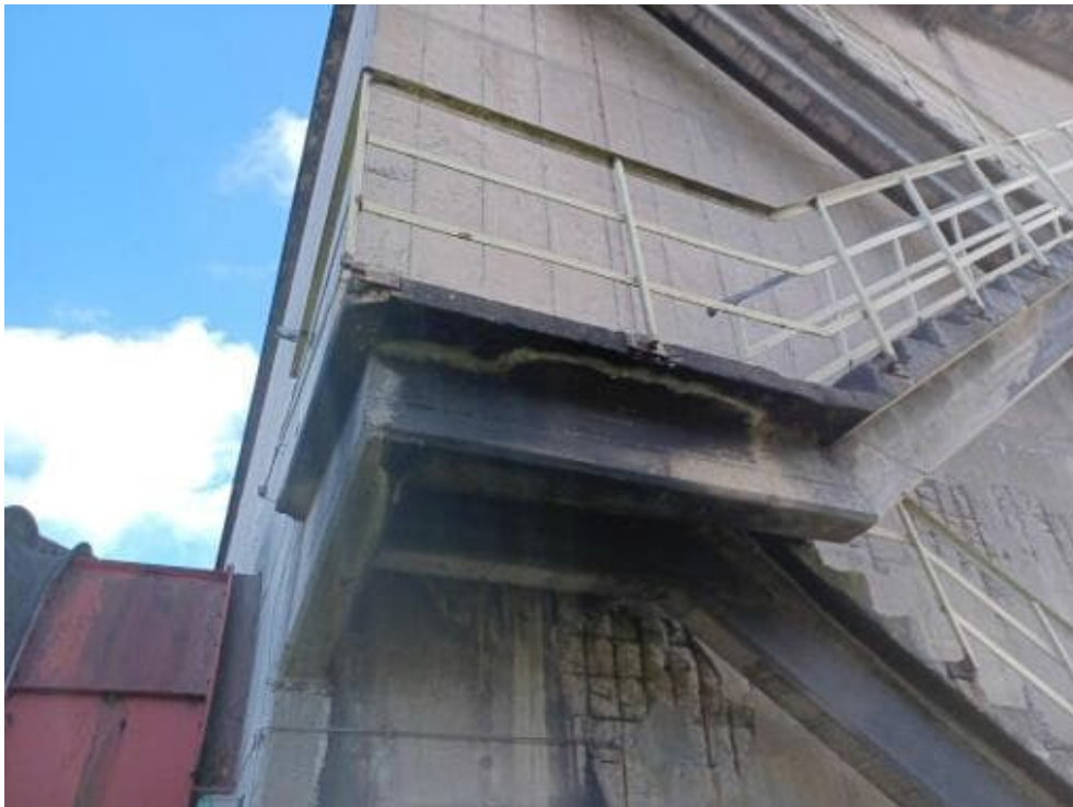
Bild 185: N72 Betonabplatzungen mit freiliegender Bewehrung und fortgeschrittenem Querschnittsverlust. Beobachtung ist mehrfach entlang Treppe feststellbar. Plattendicke: 10 cm Geländer abgängig Ausbrüche vorhanden
