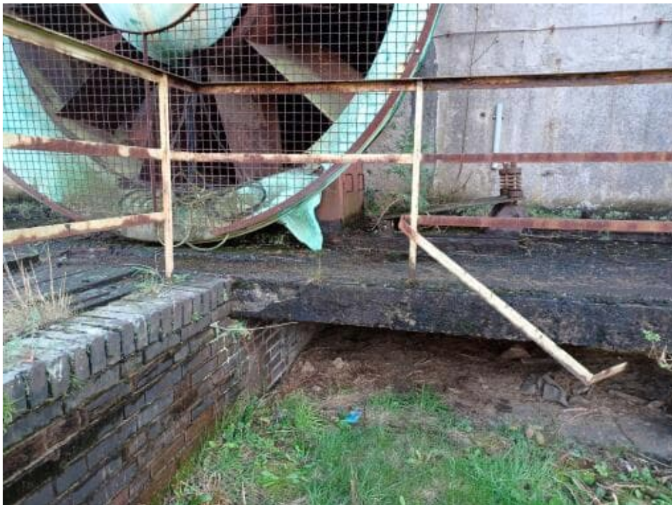
Bild 158: N64 Stahlgeländer stark abgängig bzw. nicht vorhanden -> nicht funktionsfähig
