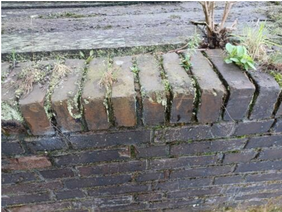
Bild 161: N65 Verblendmauerwerk Steinabmessungen: 240 x 115 x 71 (NF) Stellenweise fehlende oder gerissene Steine. Fugen teilweise nicht gefüllt und bewachsen.
