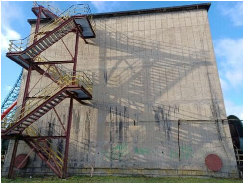
Bild 143: N61 Betonabplatzungen mit freiliegender Bewehrung und fortgeschrittenem Querschnittsverlust. Beobachtung ist auf halber Bauteilhöhe mehrfach feststellbar. Bindemittelmatrix stellenweise nicht vorhanden (Kiesnester).
