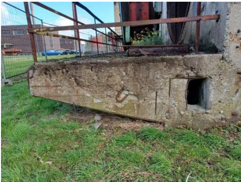
Bild 212: N84 Vouten unter Kragplatte Lichte Bauteilhöhe 50 - 60 cm
