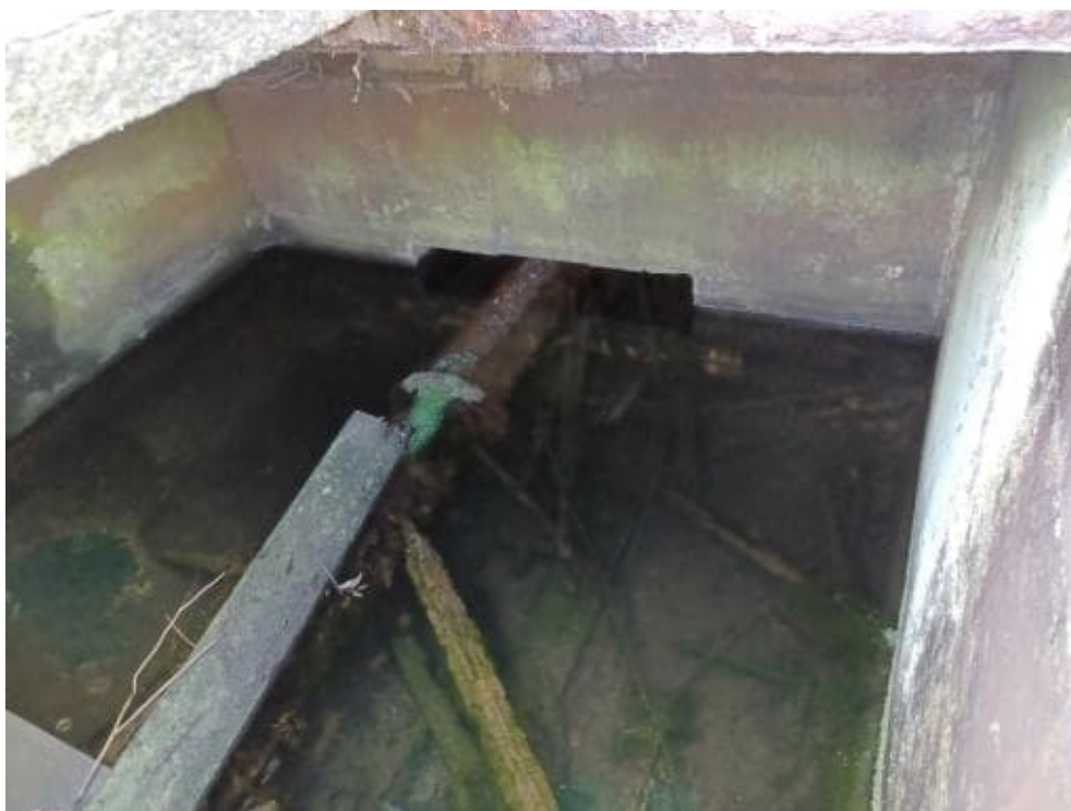
Bild 177: N70 Antriebstechnik korrodiert, Korrosionsschutz nicht vorhanden.
