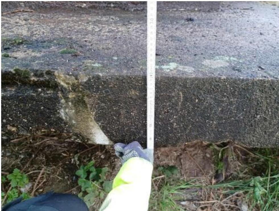
Bild 183: N71 Kragplatte gevoutet
