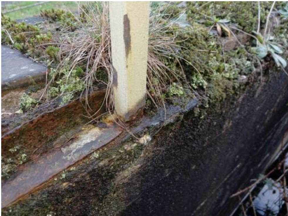
Bild 155: N64 Stahlgeländer stark abgängig bzw. nicht vorhanden -> nicht funktionsfähig
