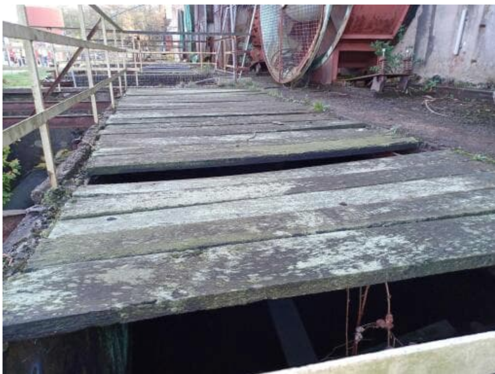
Bild 175: N69 Vorkoammern mit Holzbohlen abgedeckt
