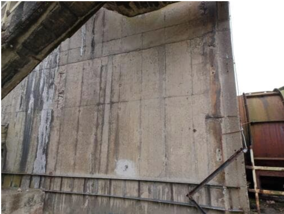
Bild 23: N14 Bewehrungsdetektion horizontal, 2x vertikal FS 683-685, Abstand Längsbewehrung vor Ort gemessen: ca. 15 cm
