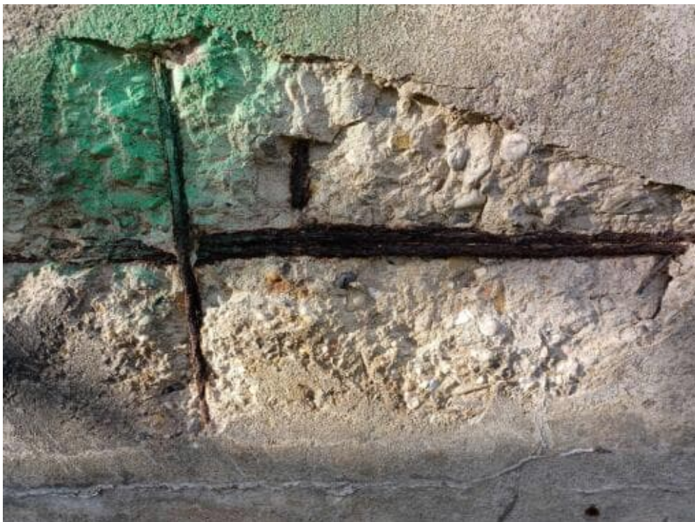
Bild 142: N61 Betonabplatzungen mit freiliegender Bewehrung und fortgeschrittenem Querschnittsverlust. Beobachtung ist auf halber Bauteilhöhe mehrfach feststellbar. Bindemittelmatrix stellenweise nicht vorhanden (Kiesnester).
