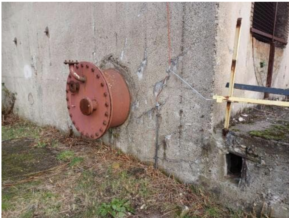
Bild 217: N85 Risse und Aussitterungen vorhanden
