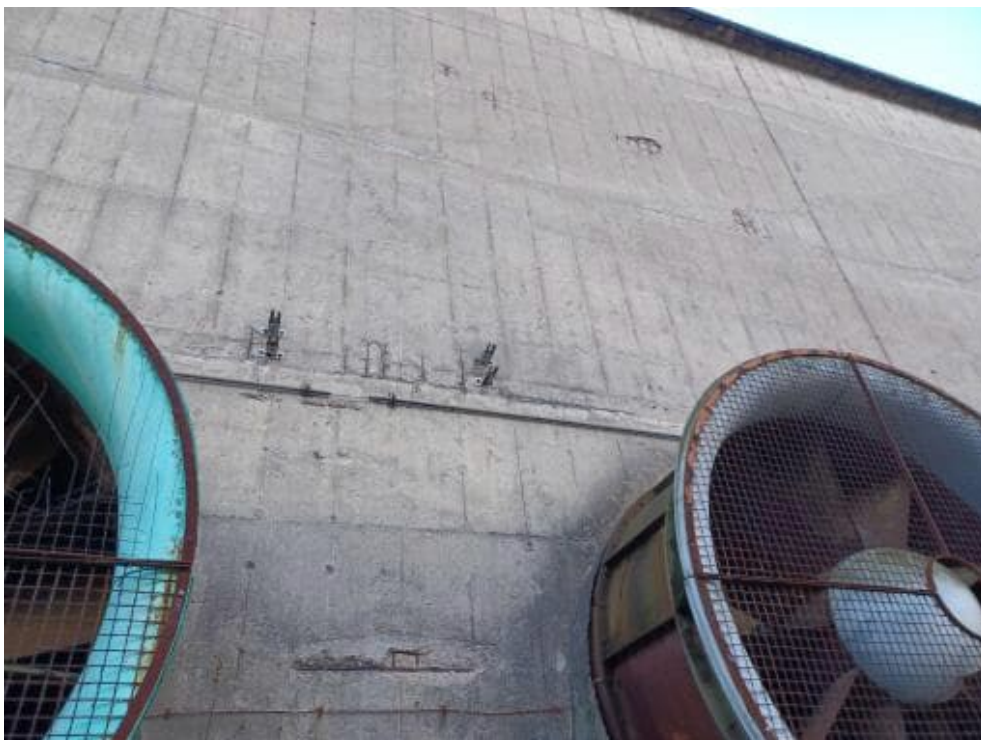
Bild 170: N67 Betonabplatzungen mit freiliegender Bewehrung und fortgeschrittenem Querschnittsverlust. Beobachtung ist auf gesamter Bauteilhöhe vereinzelt feststellbar.
