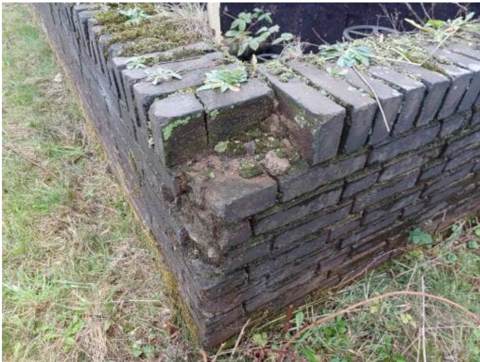
Bild 160: N65 Verblendmauerwerk Steinabmessungen: 240 x 115 x 71 (NF) Stellenweise fehlende oder gerissene Steine. Fugen teilweise nicht gefüllt und bewachsen.
