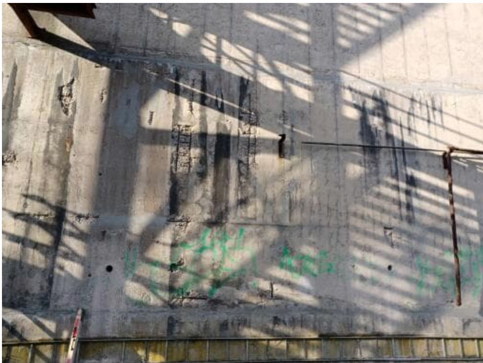
Bild 144: N61 Betonabplatzungen mit freiliegender Bewehrung und fortgeschrittenem Querschnittsverlust. Beobachtung ist auf halber Bauteilhöhe mehrfach feststellbar. Bindemittelmatrix stellenweise nicht vorhanden (Kiesnester).
