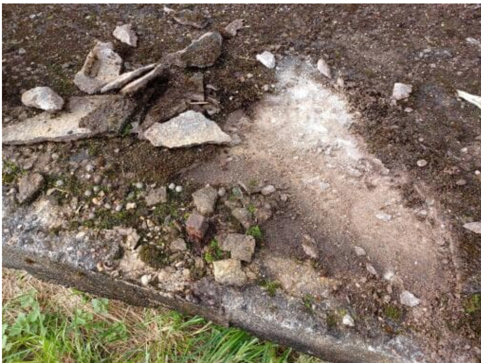
Bild 42: N23 Bohrmehlentnahme 0-20, 20-40 Cl8.1 und Cl8.2, Karbonatisierung K < 1\text{mm} Kragplatte, Mörtel vorher entfernt
