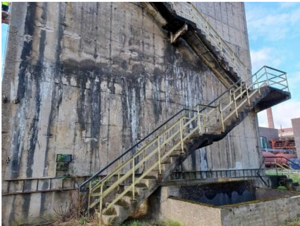
Bild 207: N80 Aussitterungen auf halber Bauteilhöhe vorhanden.
