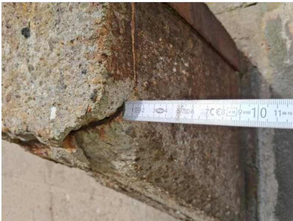
Bild 108: N48 Karbonatisierungsprüfung K10, K = 10 mm, Betondeckung c_v = 10 mm
