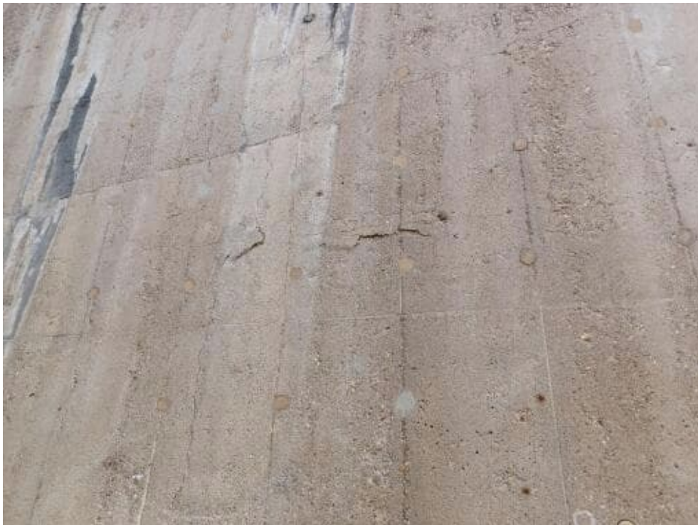
Bild 193: N74 Betonabplatzungen mit freiliegender Bewehrung und fortgeschrittenem Querschnittsverlust. Beobachtung ist auf halber Bauteilhöhe mehrfach vorhanden. Hohllagen auf gesamter Bauteilhöhe vorhanden.
