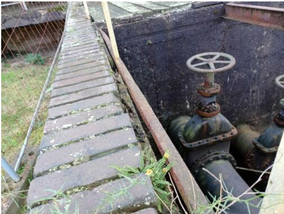
Bild 148: N64 Stahlgeländer stark abgänglich bzw. nicht vorhanden -> nicht funktionsfähig
