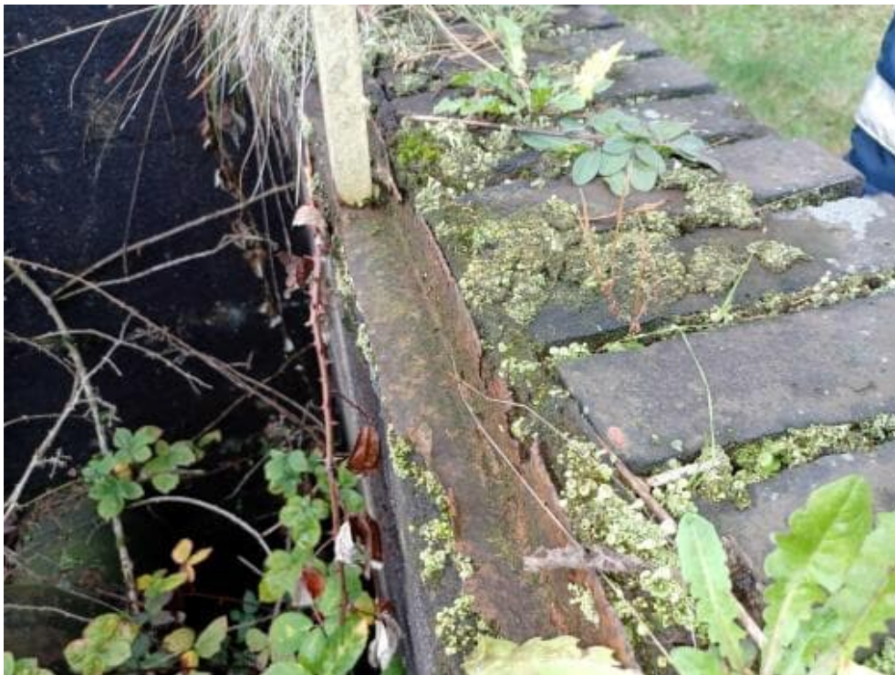
Bild 156: N64 Stahlgeländer stark abgängig bzw. nicht vorhanden -> nicht funktionsfähig
