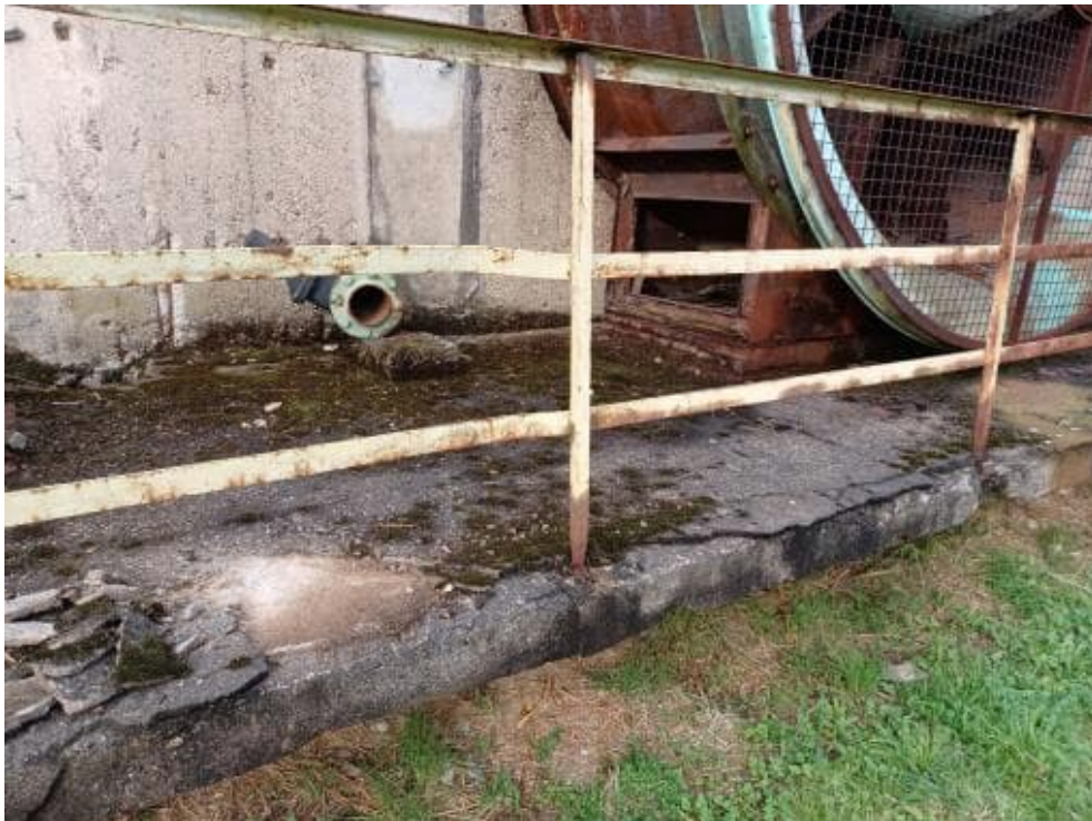
Bild 39: N22 Bohrmehlentnahme 0-20, 20-40 CI7.1 und CI7.2, Karbonatisierung K < 1\text{mm} Kragplatte, Mörtel vorher entfernt.
