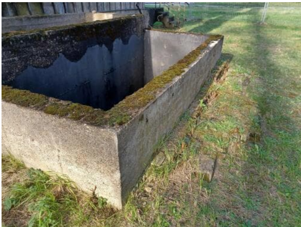
Bild 208: N81 Verblendmauerwerk nicht mehr vorhanden.
