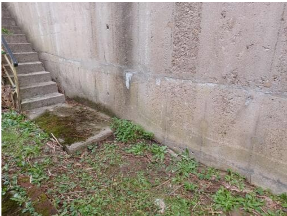
Bild 13: N8 Bohrmehlentnahme 0-20, 20-40 mm CI 3.1 und 3.2
