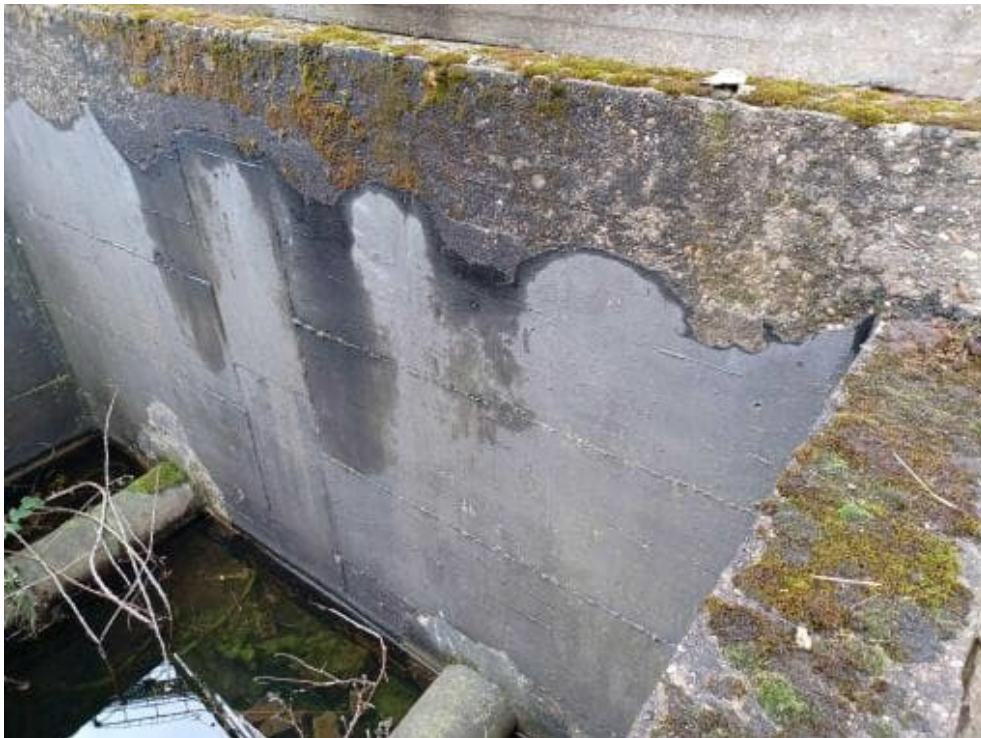
Bild 5: N4 Probe S3 Schadstoffanalyse Schwarzer Anstrich
