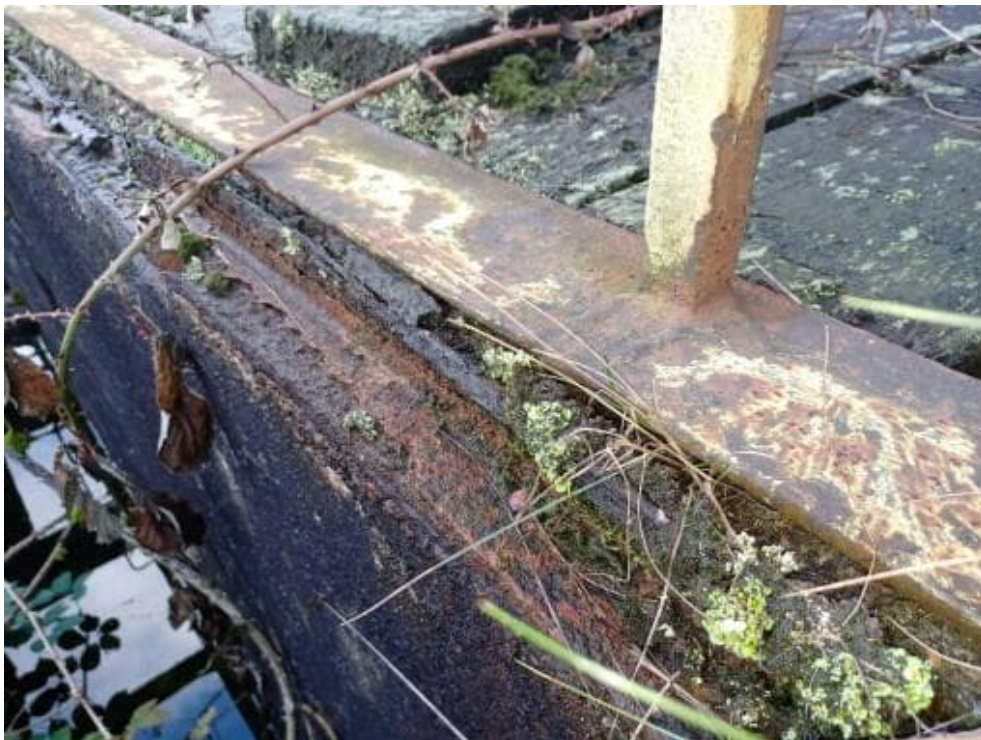
Bild 152: N64 Stahlgeländer stark abgängig bzw. nicht vorhanden -> nicht funktionsfähig
