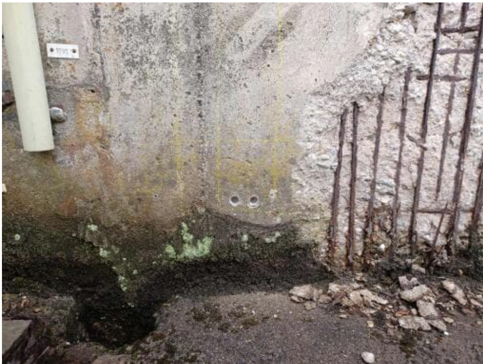
Bild 16: N10 Bohrmehlentnahme 0-20, 20-40 mm CI 6.1 und 6.2
