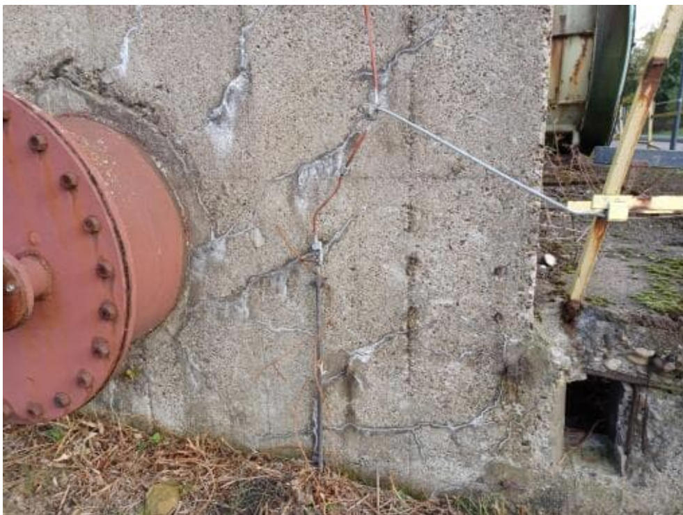
Bild 216: N85 Risse und Aussitterungen vorhanden
