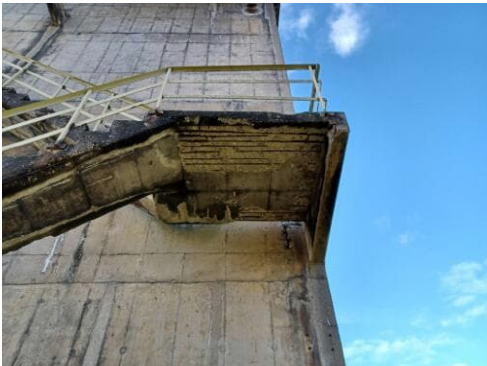
Bild 204: N79 Betonabplatzungen mit freiliegender Bewehrung und fortgeschrittenem Querschnittsverlust. Beobachtung ist mehrfach entlang Treppe feststellbar. Plattendicke: 10 cm Geländer abgänglich Ausbrüche vorhanden
