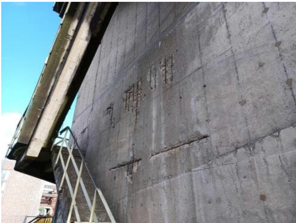
Bild 192: N74 Betonabplatzungen mit freiliegender Bewehrung und fortgeschrittenem Querschnittsverlust. Beobachtung ist auf halber Bauteilhöhe mehrfach vorhanden. Hohllagen auf gesamter Bauteilhöhe vorhanden.
