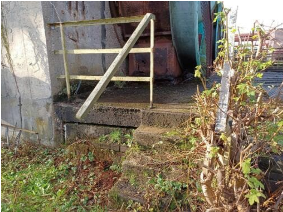
Bild 159: N64 Stahlgeländer stark abgängig bzw. nicht vorhanden -> nicht funktionsfähig
