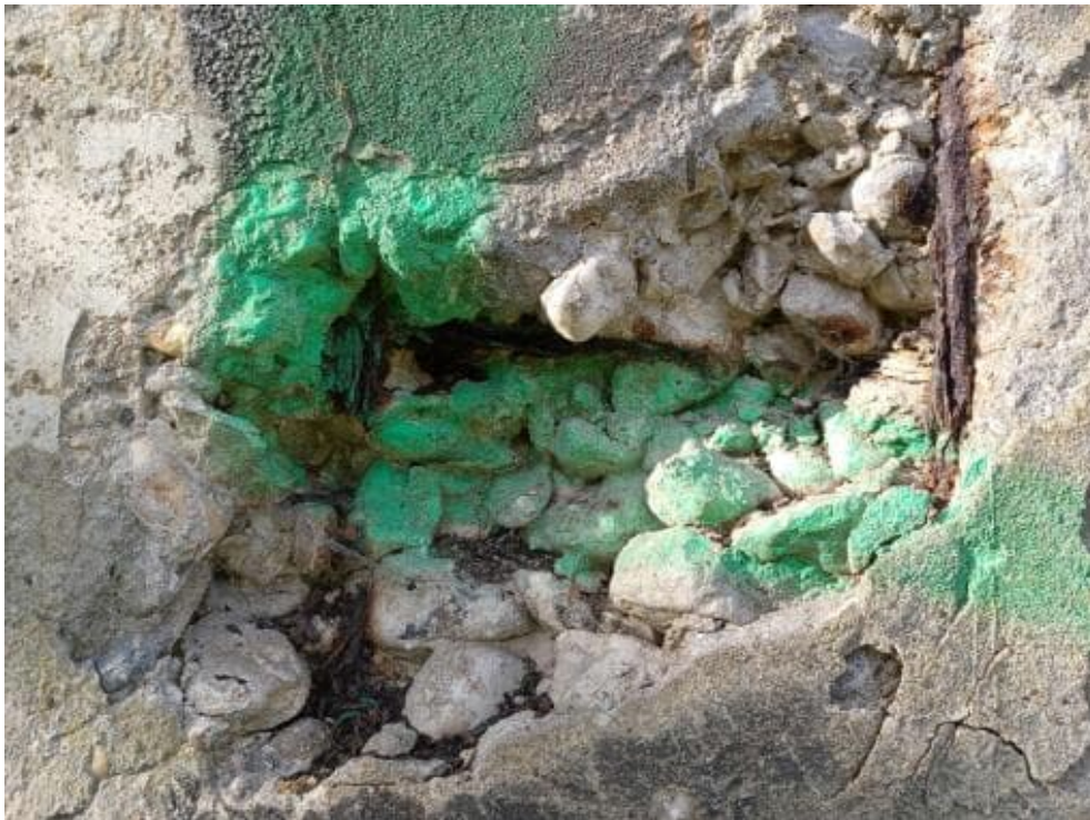
Bild 141: N61 Betonabplatzungen mit freiliegender Bewehrung und fortgeschrittenem Querschnittsverlust. Beobachtung ist auf halber Bauteilhöhe mehrfach feststellbar. Bindemittelmatrix stellenweise nicht vorhanden (Kiesnester).
