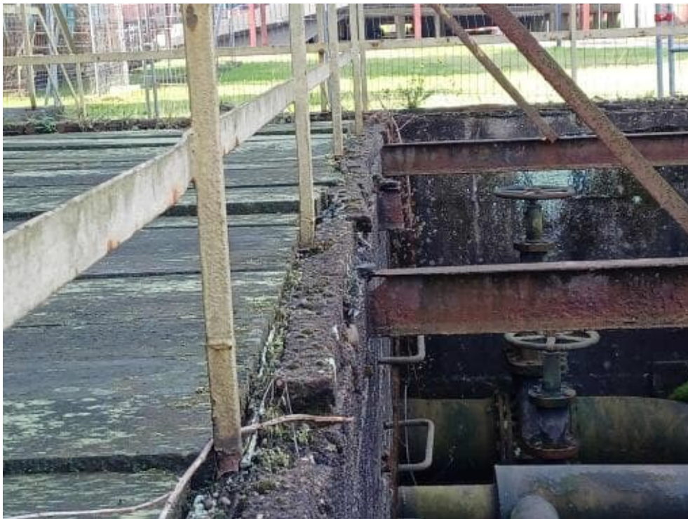
Bild 150: N64 Stahlgeländer stark abgängig bzw. nicht vorhanden -> nicht funktionsfähig
