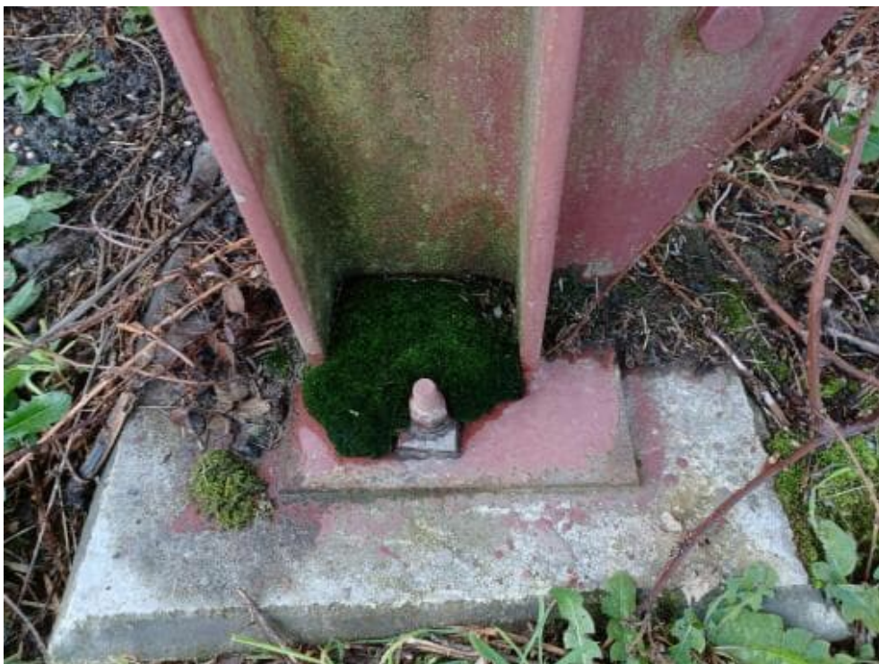
Bild 138: N60 Fußpunkte exzentrisch auf Fundament angeordnet. Abmessungen: b=h=50\text{ cm} (vgl. Ventilatorenkühler III) Treppenturm ist generell in einem guten Zustand. Korrosionsschutzbeschichtung ist abhängig.
