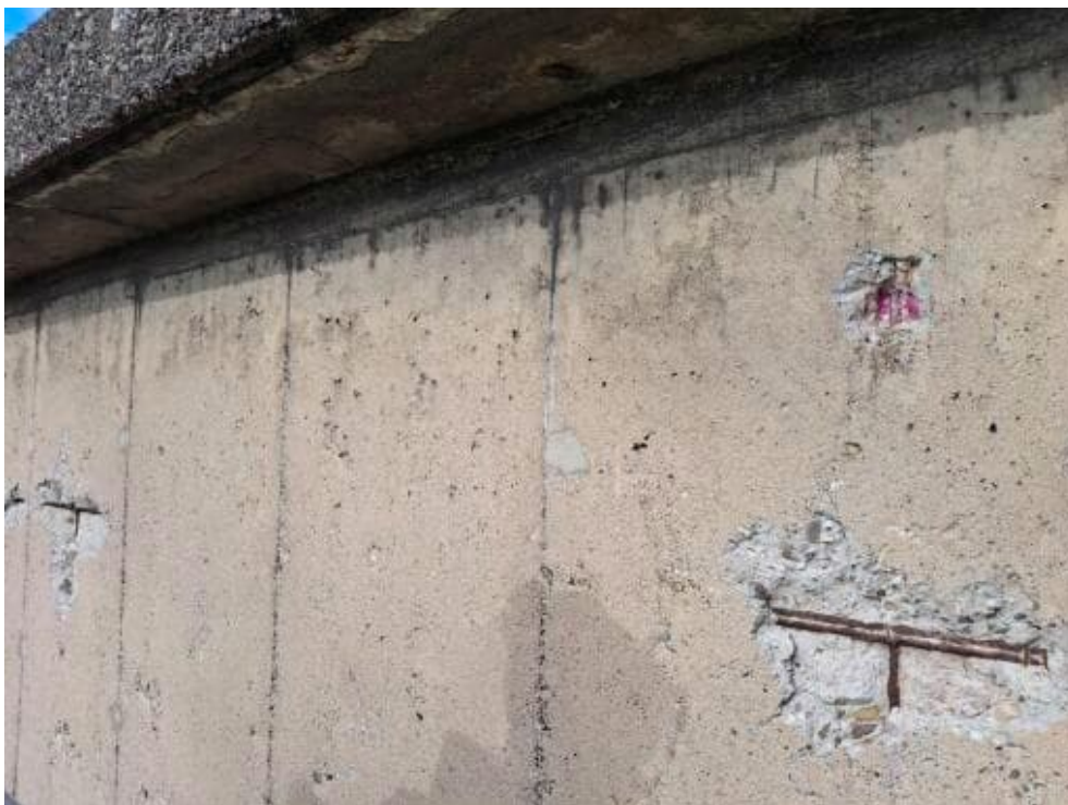
Bild 90: N43 Bewehrungsdetektion horizontal, 2x vertikal FS709-711
