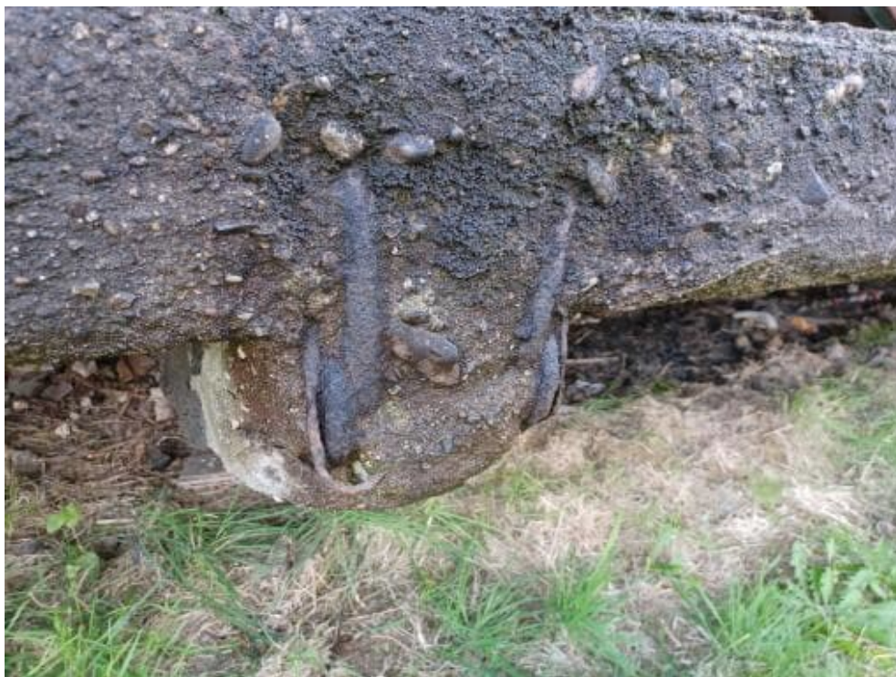
Bild 214: N84 Vouten unter Kragplatte Lichte Bauteilhöhe 50 - 60 cm
