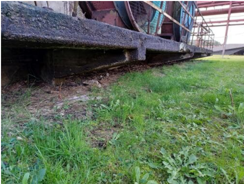
Bild 215: N84 Vouten unter Kragplatte Lichte Bauteilhöhe 50 - 60 cm
