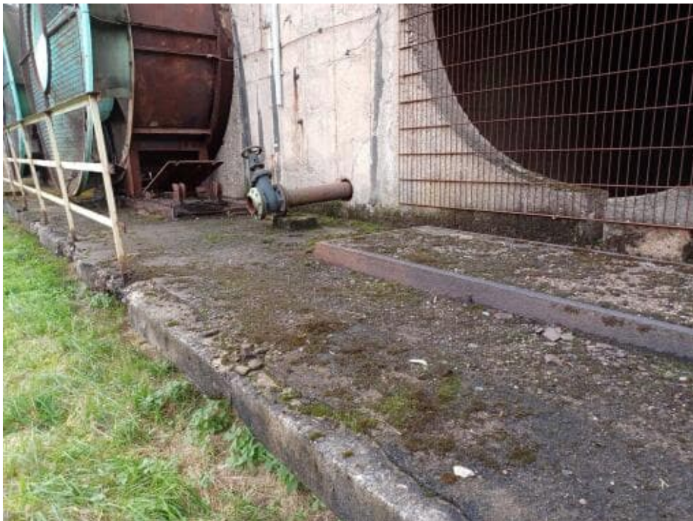
Bild 36: N21 Bewehrungsdetektion Kragplatte Ohorizontal, 2x vertikal FS 706-708, Mörtelschicht 15-25 mm
