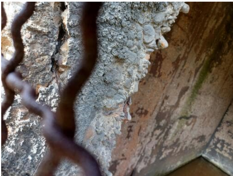
Bild 218: N86 Ventilatorrenkühler innen
