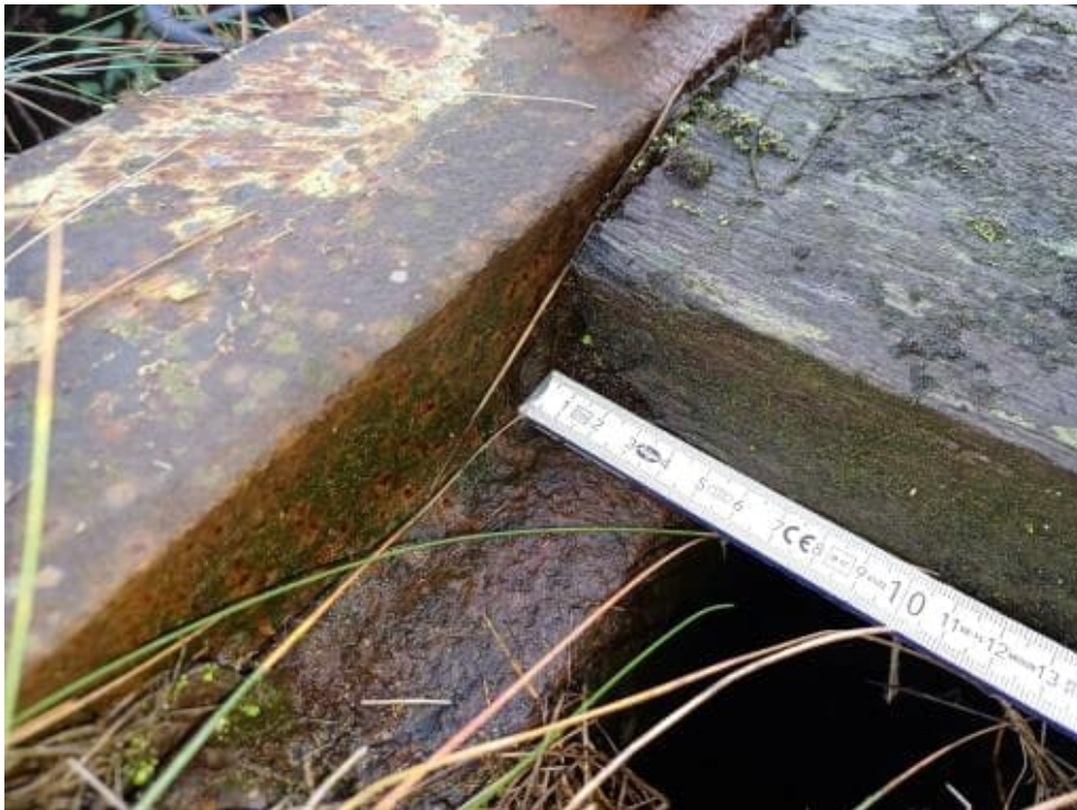
Bild 153: N64 Stahlgeländer stark abgängig bzw. nicht vorhanden -> nicht funktionsfähig
