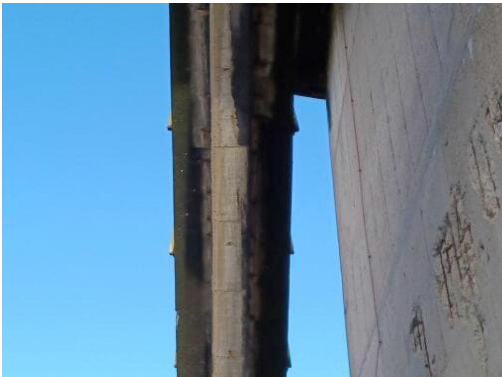
Bild 186: N72 Betonabplatzungen mit freiliegender Bewehrung und fortgeschrittenem Querschnittsverlust. Beobachtung ist mehrfach entlang Treppe feststellbar. Plattendicke: 10 cm Geländer abgängig Ausbrüche vorhanden
