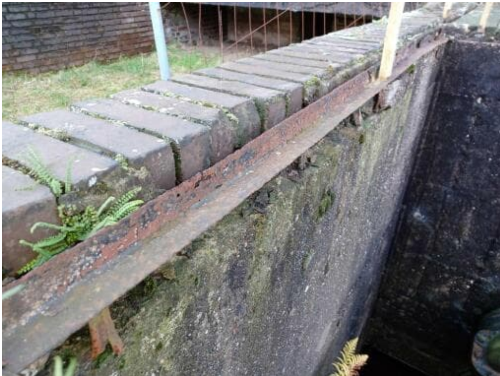
Bild 149: N64 Stahlgeländer stark abgängig bzw. nicht vorhanden -> nicht funktionsfähig
