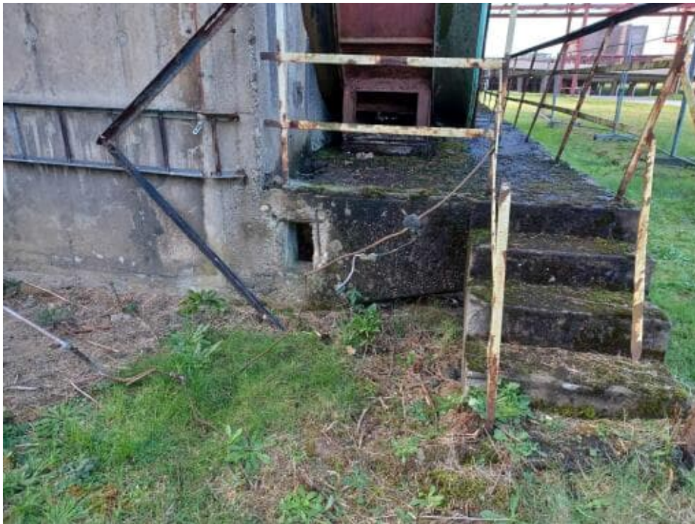
Bild 209: N82 Blitzableiter bei allen drei Ventilatorenkühlern nicht mehr funktionstüchtig
