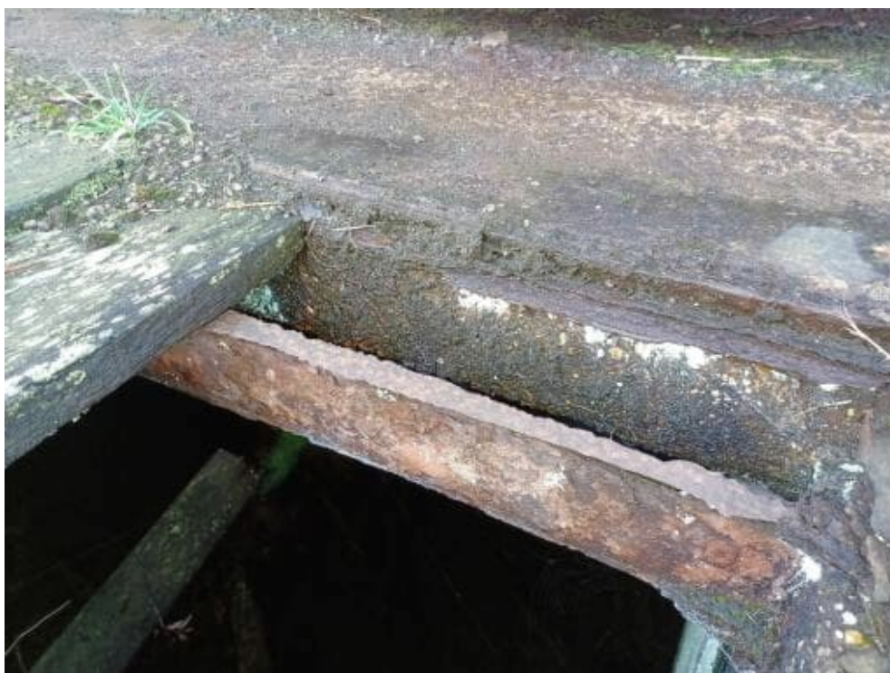
Bild 173: N69 Vorkoammern mit Holzbohlen abgedeckt
