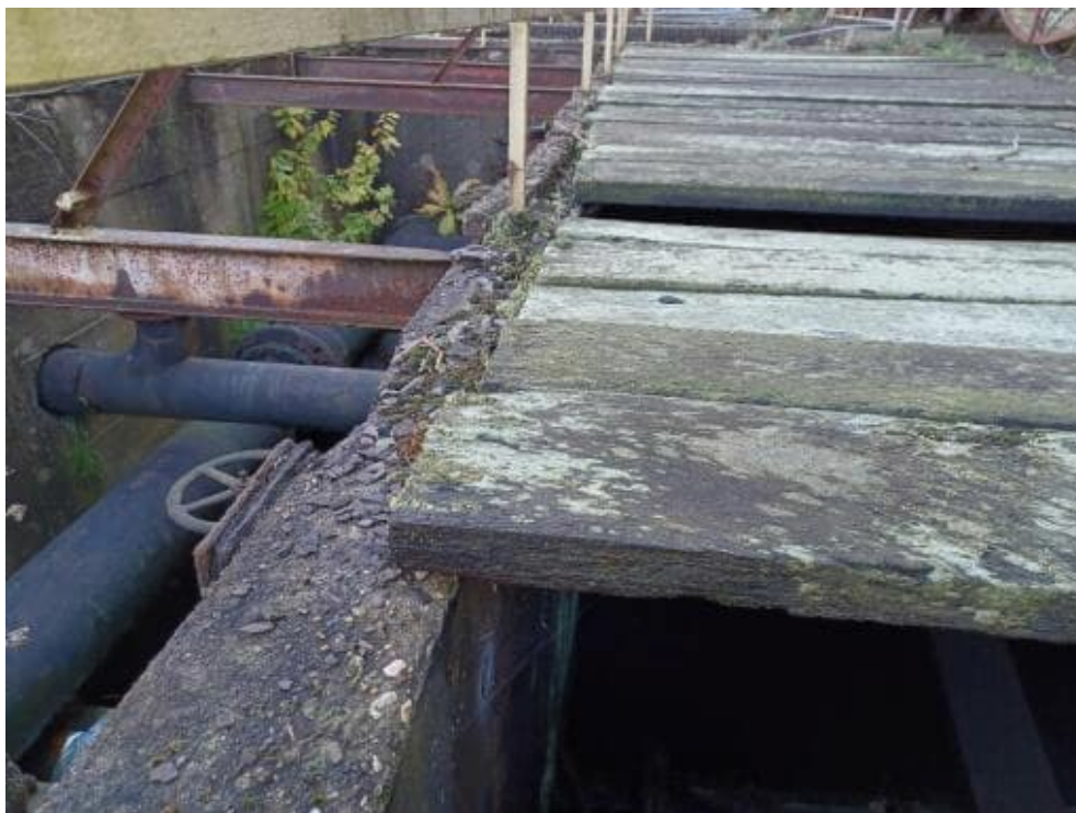
Bild 174: N69 Vorkoammern mit Holzbohlen abgedeckt
