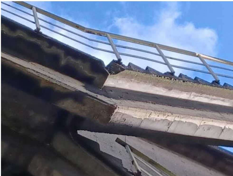
Bild 184: N72 Betonabplatzungen mit freiliegender Bewehrung und fortgeschrittenem Querschnittsverlust. Beobachtung ist mehrfach entlang Treppe feststellbar. Plattendicke: 10 cm Geländer abgänglich Ausbrüche vorhanden
