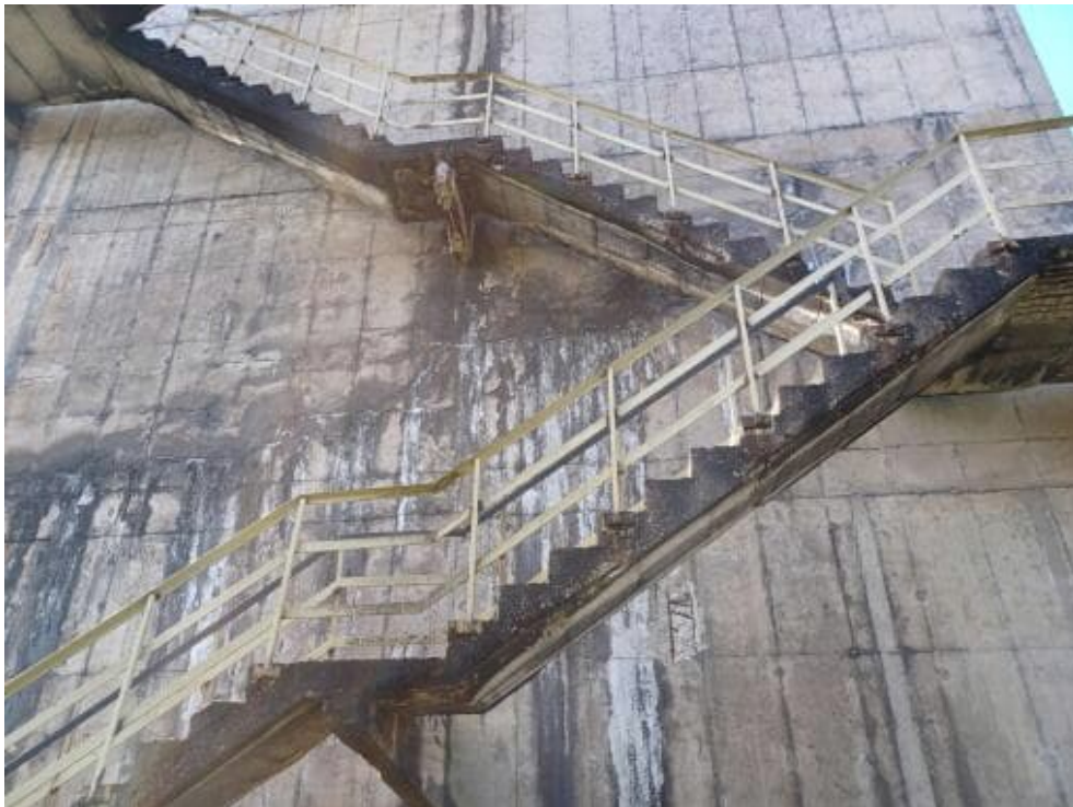
Bild 205: N79 Betonabplatzungen mit freiliegender Bewehrung und fortgeschrittenem Querschnittsverlust. Beobachtung ist mehrfach entlang Treppe feststellbar. Plattendicke: 10 cm Geländer abgänglich Ausbrüche vorhanden
