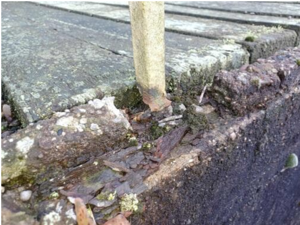
Bild 151: N64 Stahlgeländer stark abgängig bzw. nicht vorhanden -> nicht funktionsfähig
