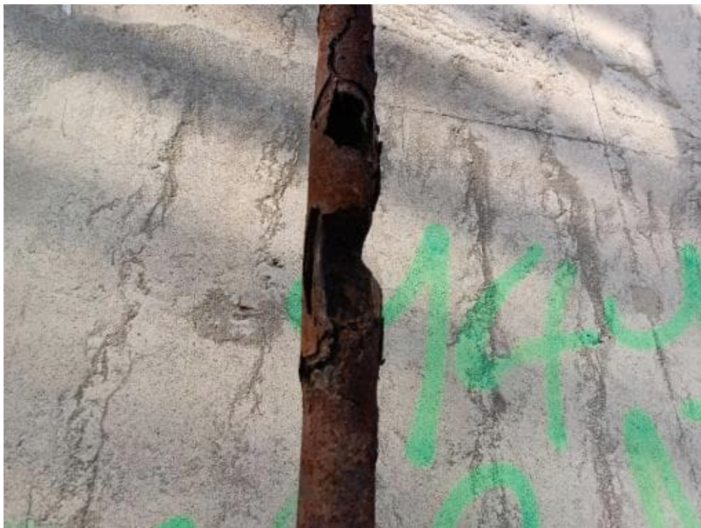
Bild 145: N62 Stahlanbauteile korrodiert
