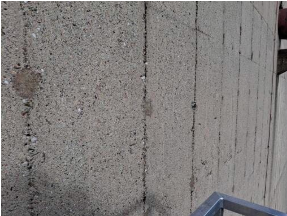
Bild 121: N53 Bewehrungsdetektion horizontal, 2x vertikal FS720-722
