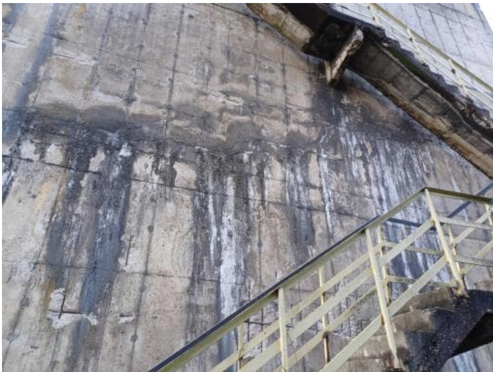
Bild 206: N80 Aussitterungen auf halber Bauteilhöhe vorhanden.
