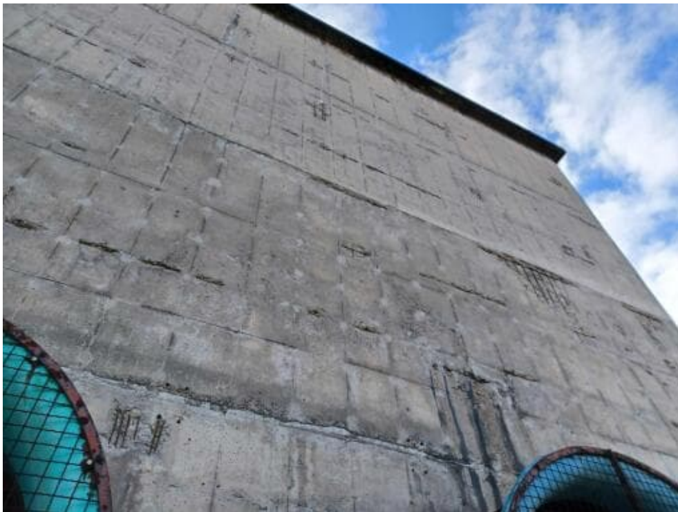
Bild 210: N83 Betonabplatzungen mit freiliegender Bewehrung und fortgeschrittenem Querschnittsverlust. Beobachtung ist auf ganzer Bauteilhöhe mehrfach feststellbar.
