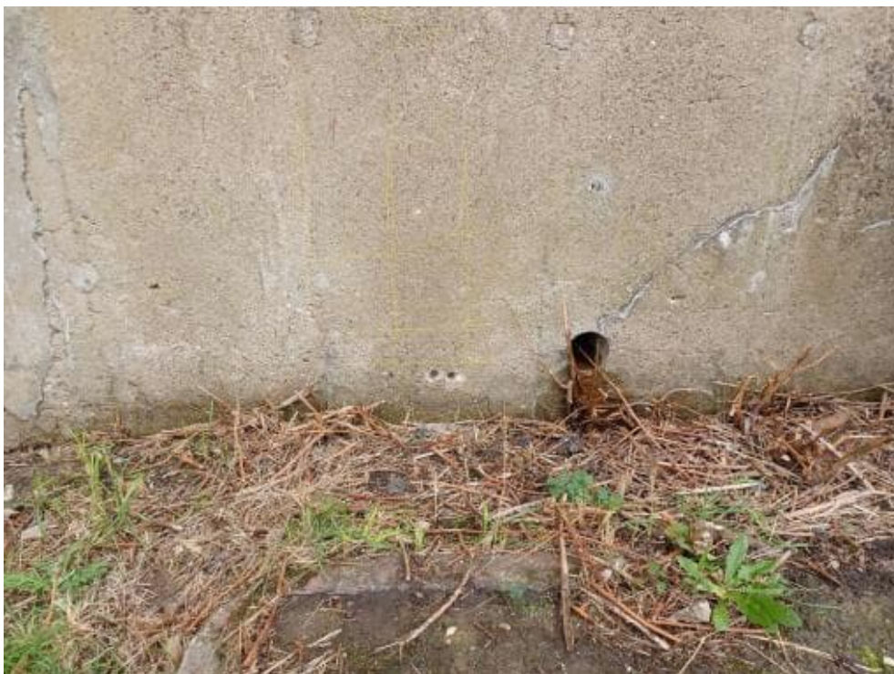
Bild 18: N11 Bohrmehlentnahme 0-20, 20-40 mm CI 5.1 und CI 5.2
