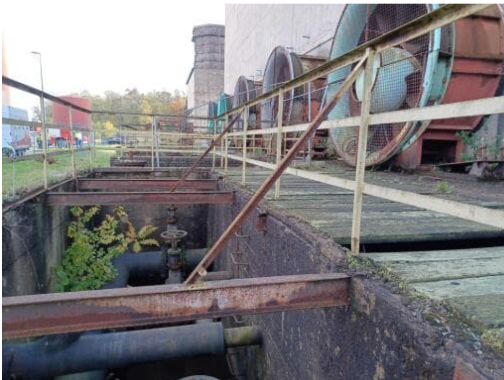
Bild 162: N66 65mm breit, 140mm hoch, I-Profil, Korrosionsschutzbeschichtung abgängig Länge Träger ca. 2,10 m
