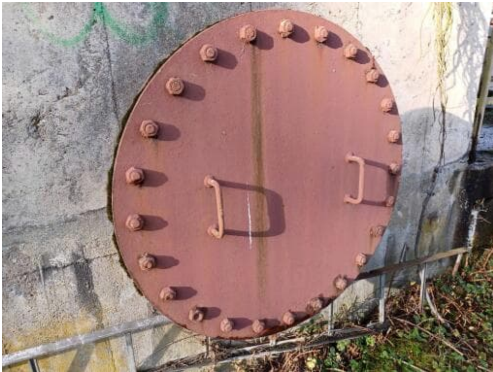
Bild 147: N63 Einstiegs Luke Durchmesser: d = 80\text{ cm}
