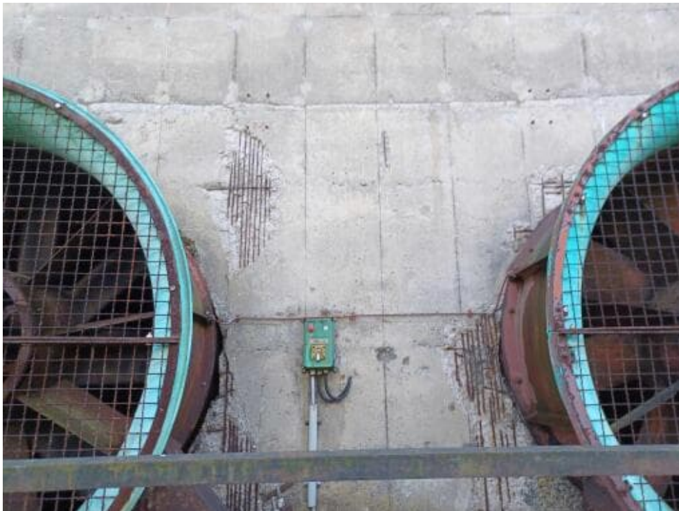
Bild 211: N83 Betonabplatzungen mit freiliegender Bewehrung und fortgeschrittenem Querschnittsverlust. Beobachtung ist auf ganzer Bauteilhöhe mehrfach feststellbar.
