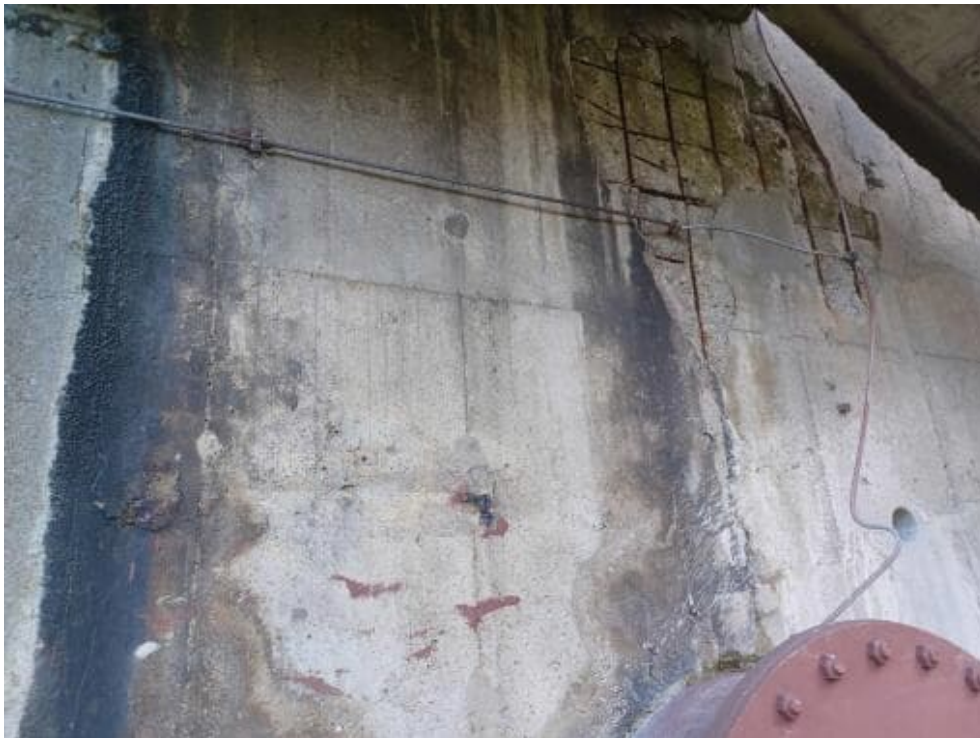
Bild 191: N74 Betonabplatzungen mit freiliegender Bewehrung und fortgeschrittenem Querschnittsverlust. Beobachtung ist auf halber Bauteilhöhe mehrfach vorhanden. Hohllagen auf gesamter Bauteilhöhe vorhanden.
