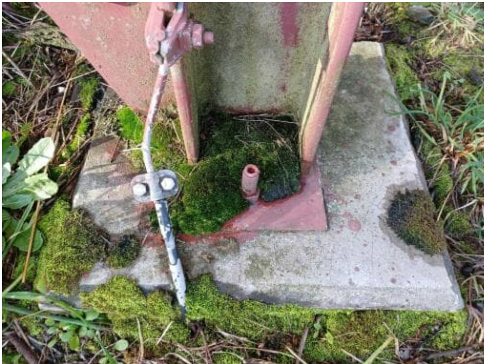
Bild 139: N60 Fußpunkte exzentrisch auf Fundament angeordnet. Abmessungen: b=h=50\text{ cm} (vgl. Ventilatorenkühler III) Treppenturm ist generell in einem guten Zustand. Korrosionsschutzbeschichtung ist abhängig.
