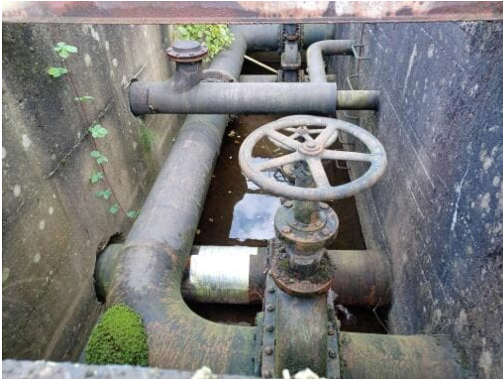
Bild 179: N70 Antriebstechnik korrodiert, Korrosionsschutz nicht vorhanden.
