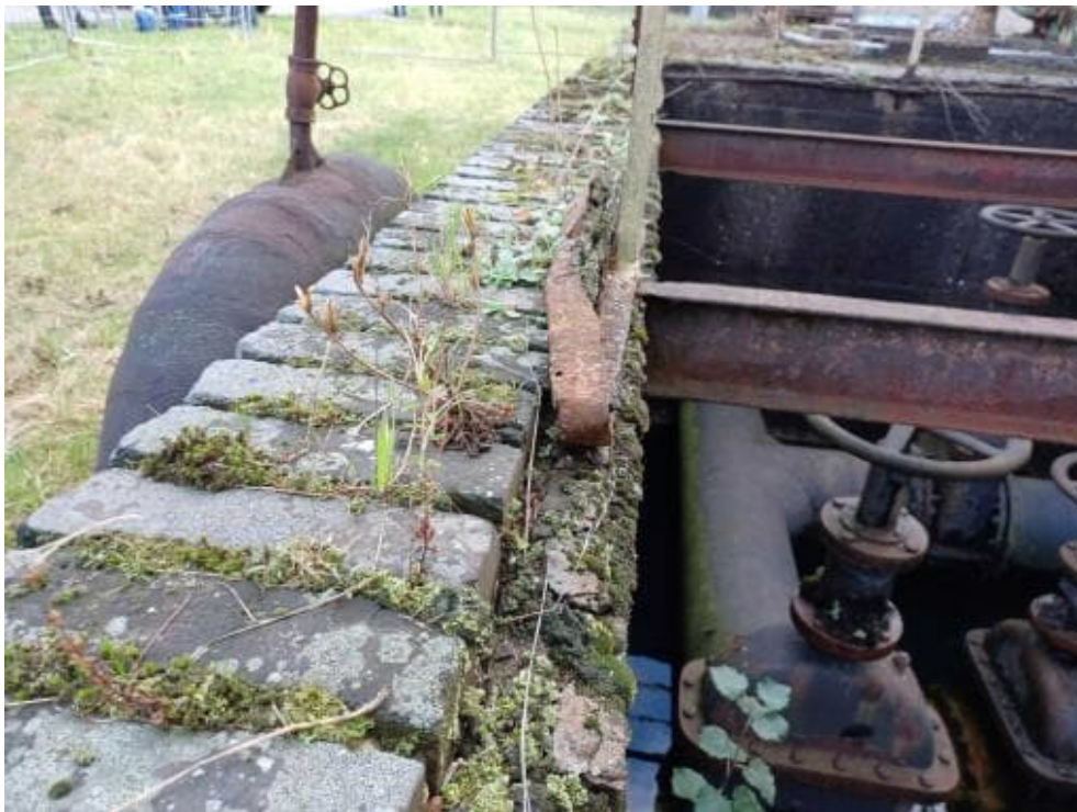
Bild 154: N64 Stahlgeländer stark abgängig bzw. nicht vorhanden -> nicht funktionsfähig
