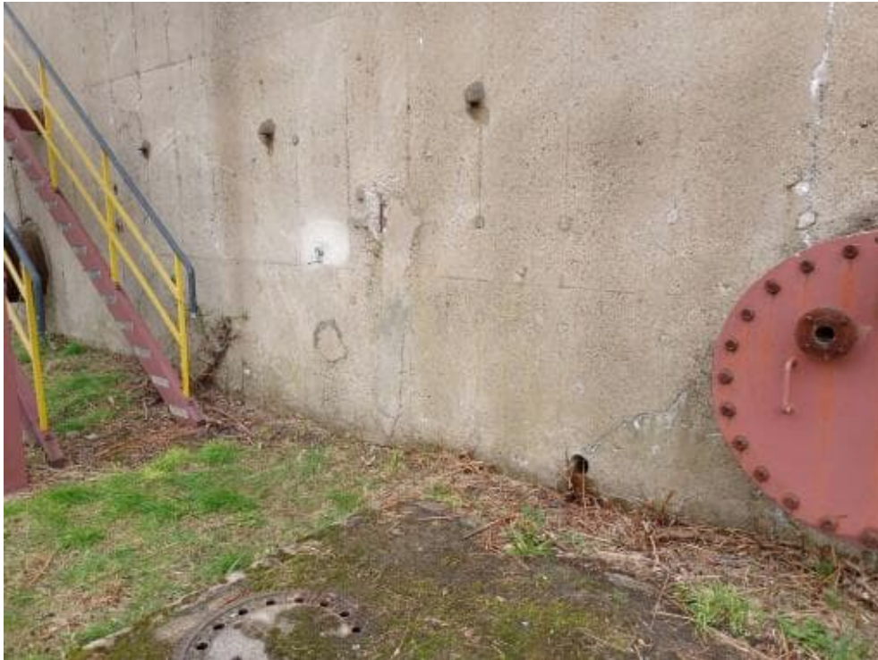
Bild 19: N11 Bohrmehlentnahme 0-20, 20-40 mm CI 5.1 und CI 5.2
