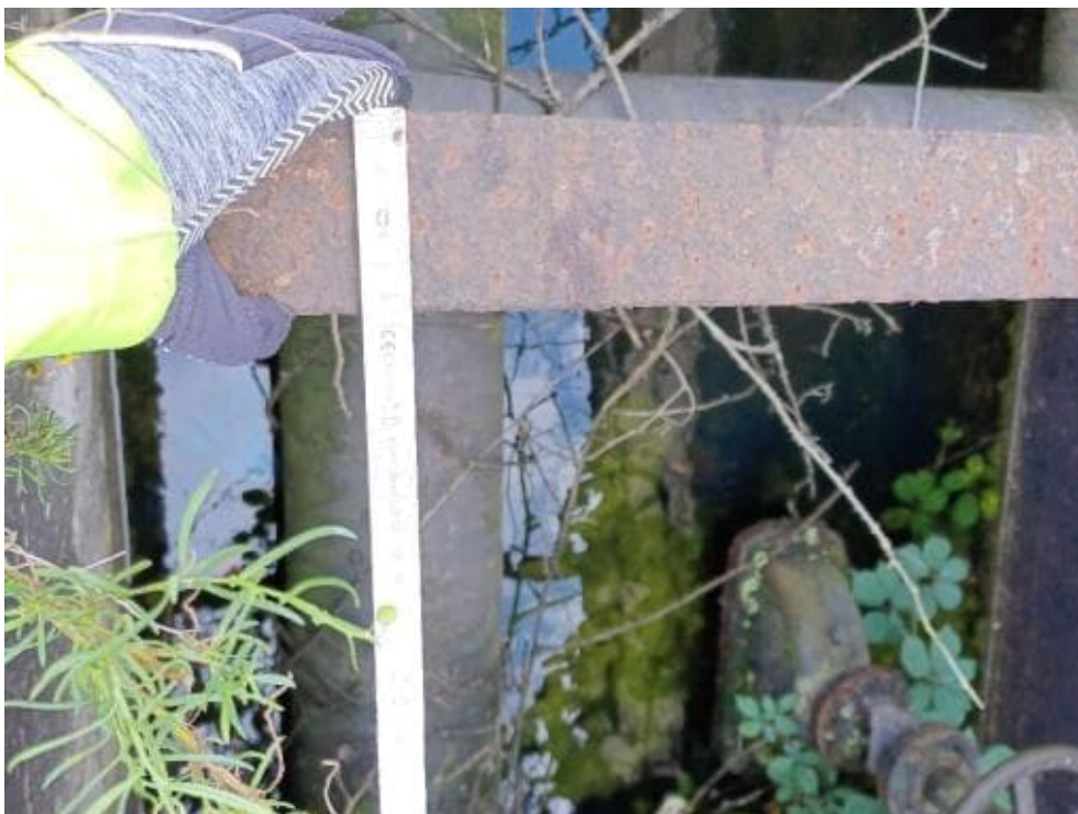
Bild 166: N66 65mm breit, 140mm hoch, I-Profil, Korrosionsschutzbeschichtung abgängig Länge Träger ca. 2,10 m
