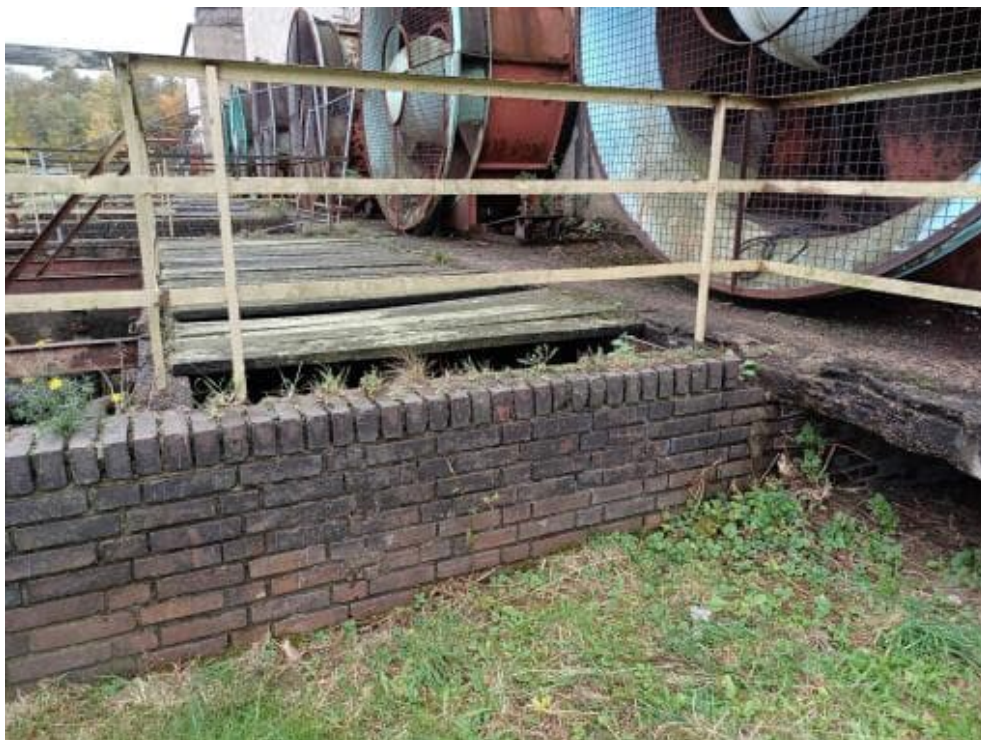
Bild 8: N5 Probe S4 Schadstoffanalyse Fugenmörtel Mauerwerk
