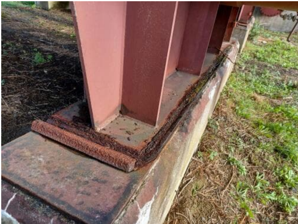
Bild 201: N78 Korrosionserscheinungen an Fußpunkten
